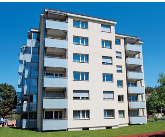
Als Pilotprojekt setzte die ASIG Wohngenossenschaft bei der Fassadenerneuerung ihrer Siedlung Wieslächer in Zürich Witikon das System «Aqua Pura Vision» ein. Die Bilanz nach drei Jahren ist positiv.
